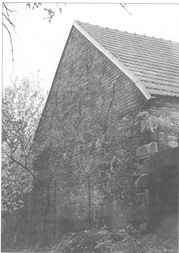
Obr. 11. Ivančice (okr. Brno-venkov). Severní štítová stěna někdejší farní stodoly. Ve zdivu (zejména při armování nároží) druhotně užity gotické architektonické články. Foto J. Doležel, říjen 2001.
