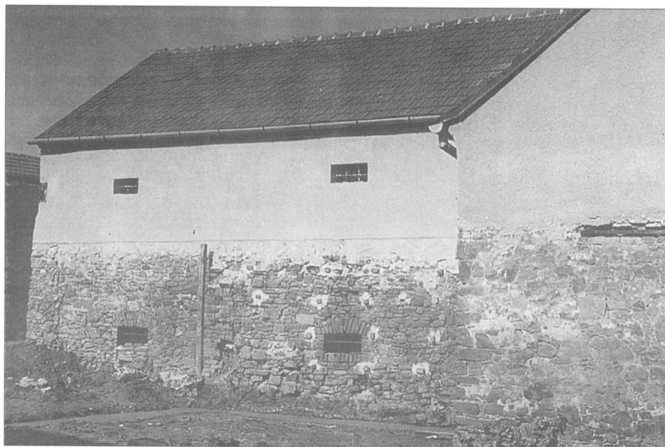
Obr. 10. Ivančice (okr. Brno-venkov). Jižní průčelí bývalé farní sýpky (nyní u č. p. 6). Foto J. Doležel, říjen 2001.
