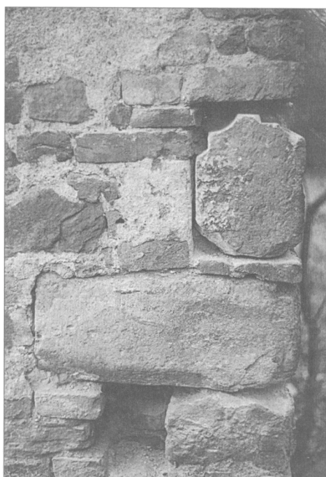
Obr. 13. Ivančice (okr. Brno-venkov). Obrubně gotického portálu s okosem a velkého obdélného okna, druhotně užitě jako stavební materiál v severovýchodním nároží bývalé farní stodoly. Foto J. Doležel, říjen 2001.
