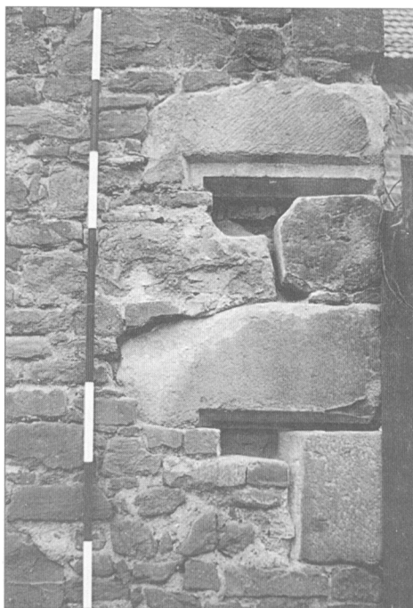
Obr. 12. Ivančice (okr. Brno-venkov). Části gotických ostění oken a portálů, sekundárně vezděné do severozápadního nároží původní farní stodoly. Foto J. Doležel, říjen 2001.
