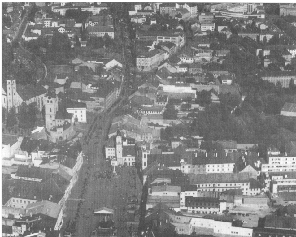
Obr. 1. Banská Bystrica – historické jadro. Objekt barbakanu je označený bielou šípkou. Foto: V. Hanuliak.
