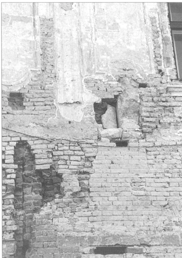
Obr. 6. Detail časti východnej fasády s nálezmi z najstaršej etapy – juhovýchodné nárožie a fragment okna pôvodného domu.
