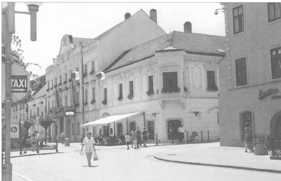
Obr. 1. Dnešný stav domu na Hlavnej ul. č. 1 v kontexte zástavby Hlavnej ulice.
