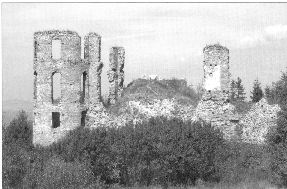
Obr. 9. Plaveč – celkový pohľad.
