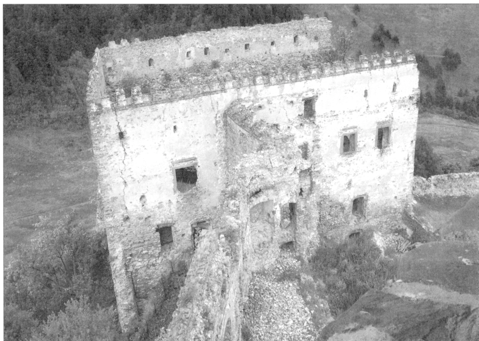
Obr. 4. Lubovňa – východný palác, pohľad z veže.
