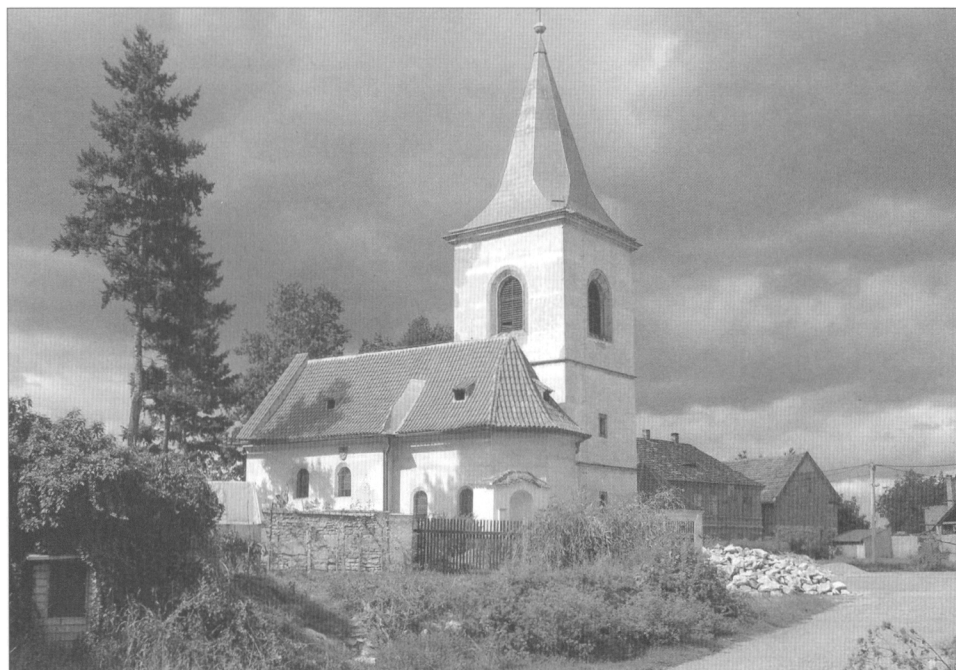
Obr. 1. Vrbno u Mělníka. Pohled na kostel od jihovýchodu.
