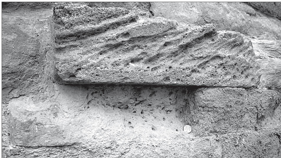
Obr. 6. Kvádre hore a dole v strede vytesané z pieskovcov. V hornom vidno šikmé zvrstvenie, čo je primárna textúra. V dolnom sa nachádzajú diery po vyvetraných úlomkoch, ktoré mohli vzniknúť i činnosťou organizmov. Južná strana apsidy.
