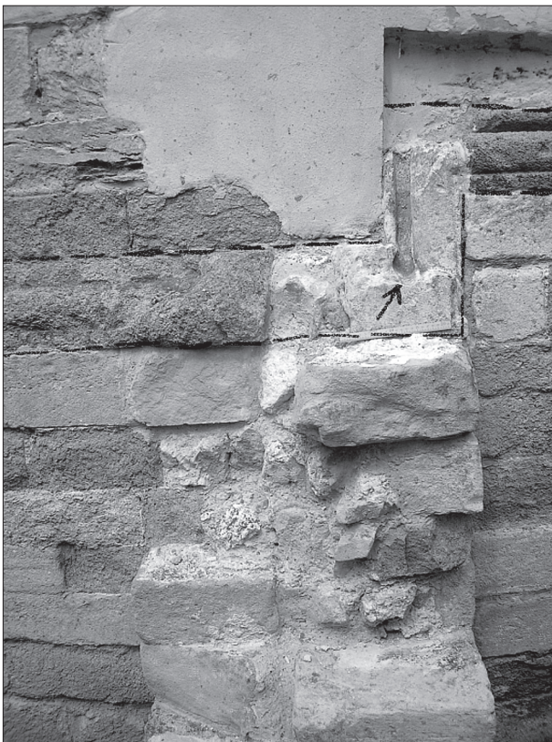
Obr. 12. Zbytok soklovej časti východného opieráku apsidy. Čiarkovanou čiarou je zvýraznený lom soklovej rimsy a šípka odtok z rimsy (?).
