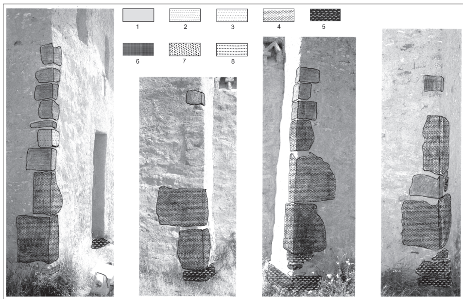
Obr. 3. Horninové zastúpenie v kvádroch jz., jv., sv. a sz. rohu Kostola sv. Michala v Dražovciach: 1 – belavý organogénny vápenc, 3 – žltkasté pieskovce, 4 – travertín až riasový vápenc, 5 – tmavosivý vápenc, 6 – bordový kremenec.
