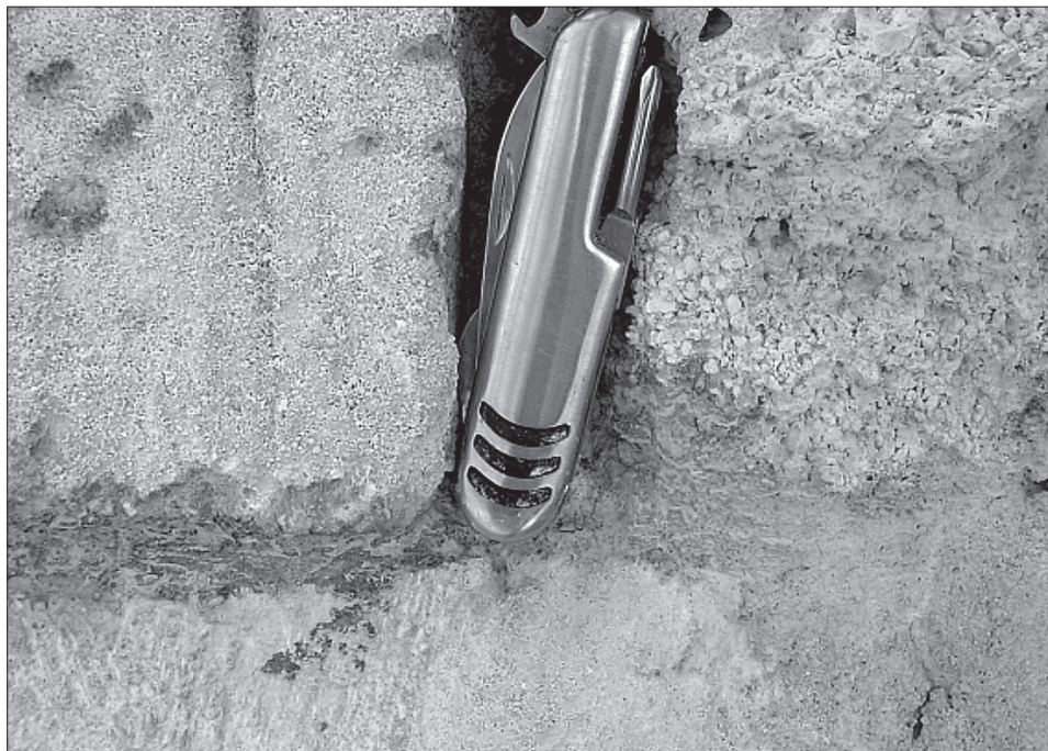
Obr. 4. Kontakt 3 kvádrov z belavého organogénneho vápenca s rozdielnou veľkosťou zrna. Vpravo hore je veľmi hrubozrnný, dole a vľavo je typický stredno- až hrubo-zrnný. Východná strana apsidy.
