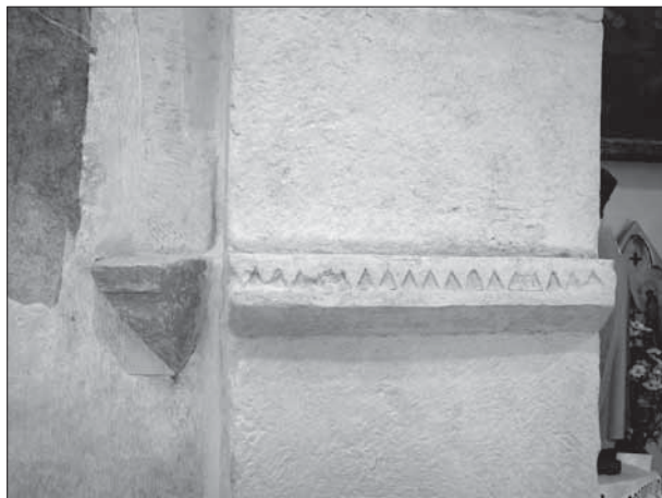
Obr. 5. Martinček, rímsa triumfálneho oblúka a konzola klenby presbytéria.
