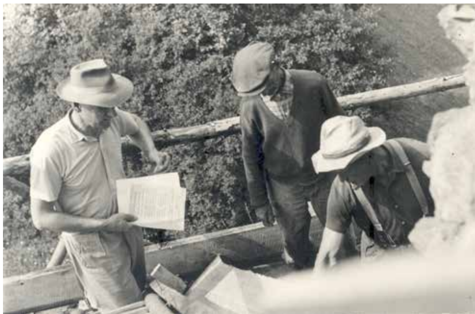
Obr. 1. Ing. B. Coufal při rekonstrukčních pracích na zdivu hradu v roce 1964. Autor B. Coufal, pozůstalost B. Coufala, archiv ÚAM.
