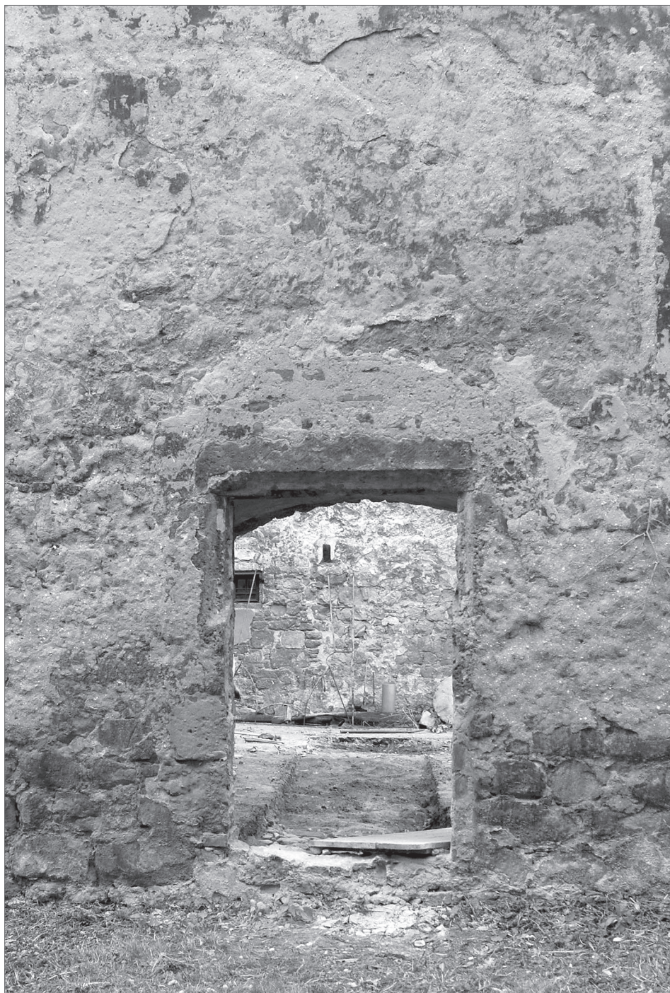
Obr. 2. Okenní otvor karlštejnského profilu upravený na dveřní otvor na severním průčelí severního křídla hradního jádra. Foto L. Kursová.
