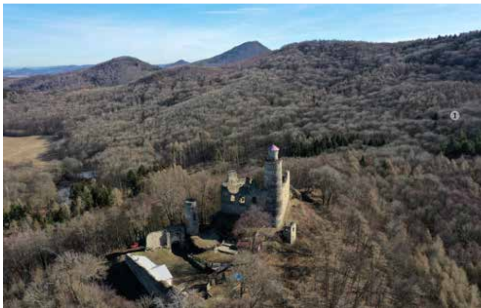
Obr. 5. Pohled přes hrad na areál I obléhacího tábora (označen č. 1). Foto M. Benda.
