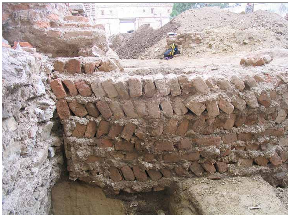
Obr. 11. Základ vymurovaný spôsobom opus spicatum odkrytý pri farskom Kostole sv. Mikuláša v Trnave.
