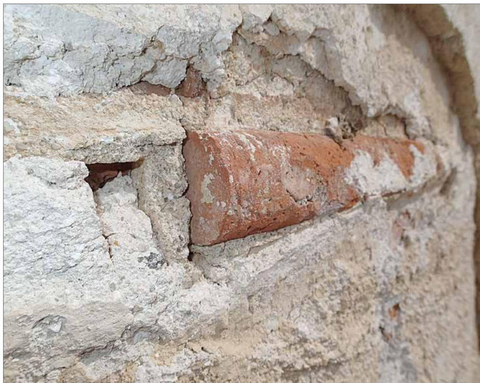
Obr. 29. Apsida Kostola Všetkých svätých v Dechticiach, fragmenty pôvodných oblúkových čiel predstúpených riadkov tehál, zistené počas reštaurátorského odkryvu.
