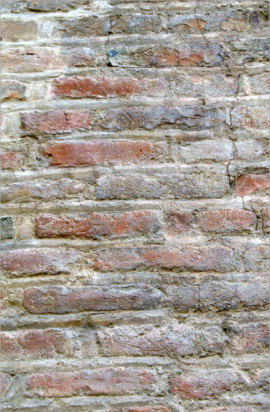
Obr. 9. Typ škárovania s maltou vyprofilovanou do trojuholníka, meštiansky dom v Trnave, Hlavná 5, začiatok 14. storočia (?). Abb. 9. Verfugungstyp mit keilförmig profiliertem Mörtel, Bürgerhaus in Trnava. Hlavná-Str. 5, Anfang 14. Jahrhundert (?).
