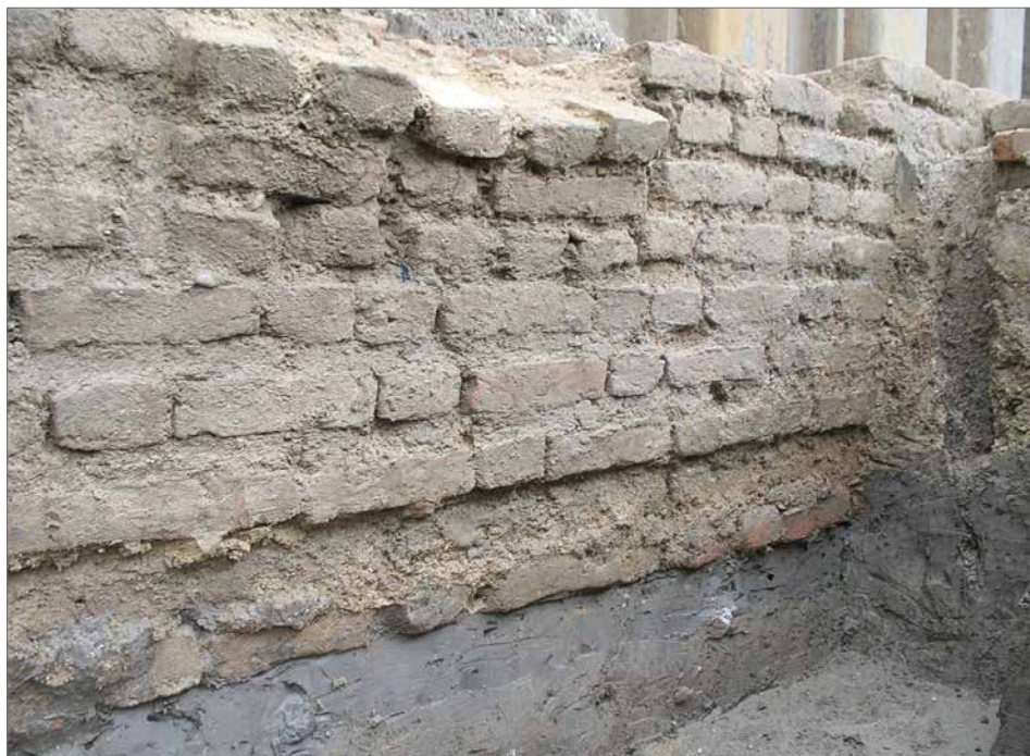
Obr. 3. Príklad najstaršieho a v Trnave najčastejšie používaného podrezávaného škárovania, spodný úsek steny zahĺbeného podlažia, parcela bývalého Selepčeniho domu, okolo polovice 13. storočia.
