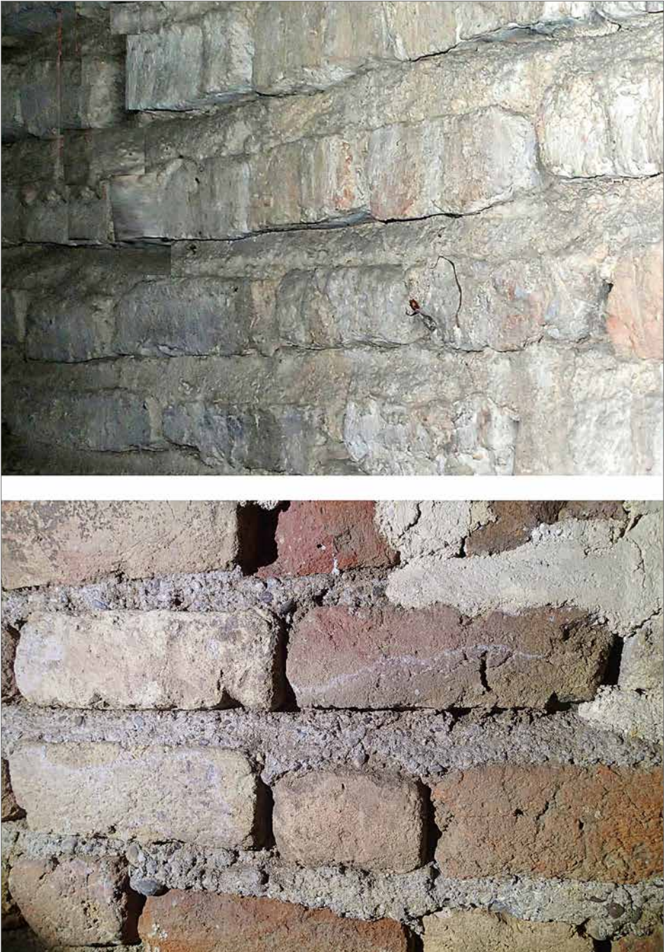
Obr. 4. Príklad najstaršieho a v Trnave najčastejšie používaného podrezávaného škárovania. Hore: sklopené škáry, Kostol sv. Martina v Hrnčiarovciach nad Parnou; dole: škáry zarovnané do vertikálnej roviny, jedna z primárnych veží mestského opevnenia, obe stavby okolo polovice 13. storočia.
