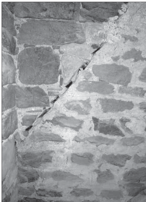
Obr. 2. Bernartice, kostel sv. Martina. Pata severního ramene štítu z interiéru věže se středními latěmi. Foto J. Varhaník, 2009.
