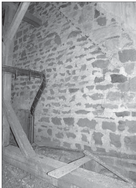
Obr. 1. Bernartice, kostel sv. Martina. Východní zeď věže románského kostela založená na západním štítu lodi s pozůstatky latí původního zastřešení ve spáře mezi oběma konstrukcemi. Foto J. Varhaník, 2009.
