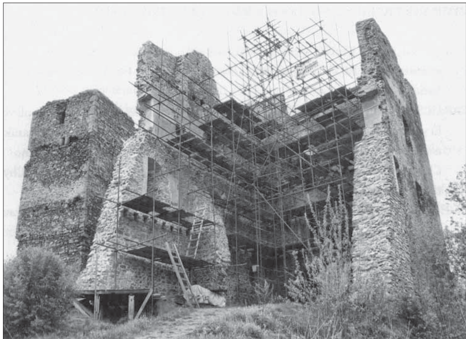
Obr. 6. Hrad Rokštejn, k. ú. Panská Lhota, město Brtnice. Horní palác a věž v letech 2005–2007 při restauraci a stabilizaci zdiva. Podle Měřinský 2007. Foto S. Jirků.
