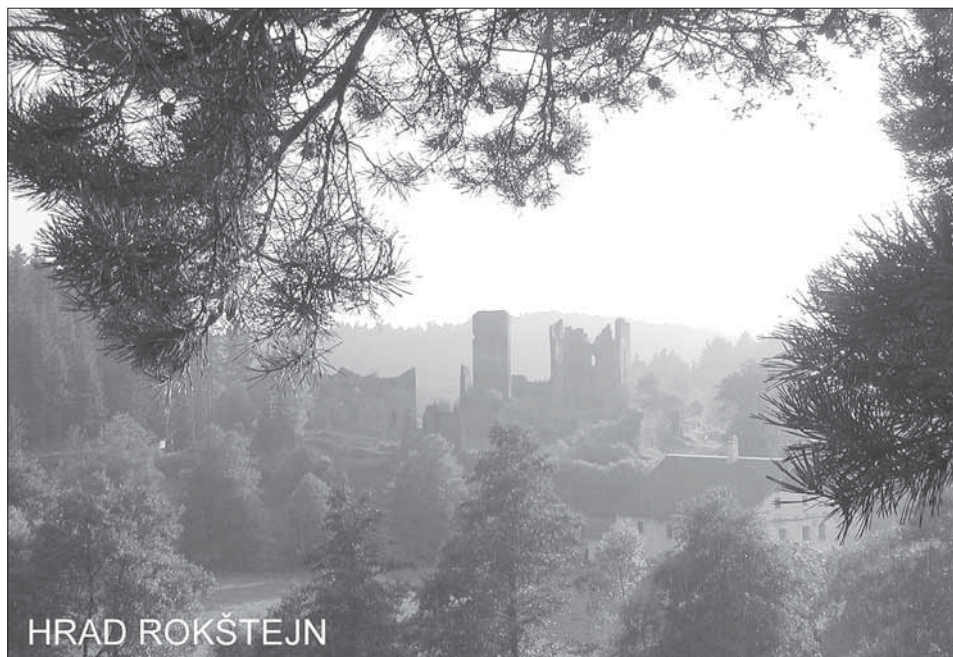
Obr. 1. Hrad Rokštejn, celkový pohled. Abb. 1. Burg Rokštejn, Gesamtansicht.
