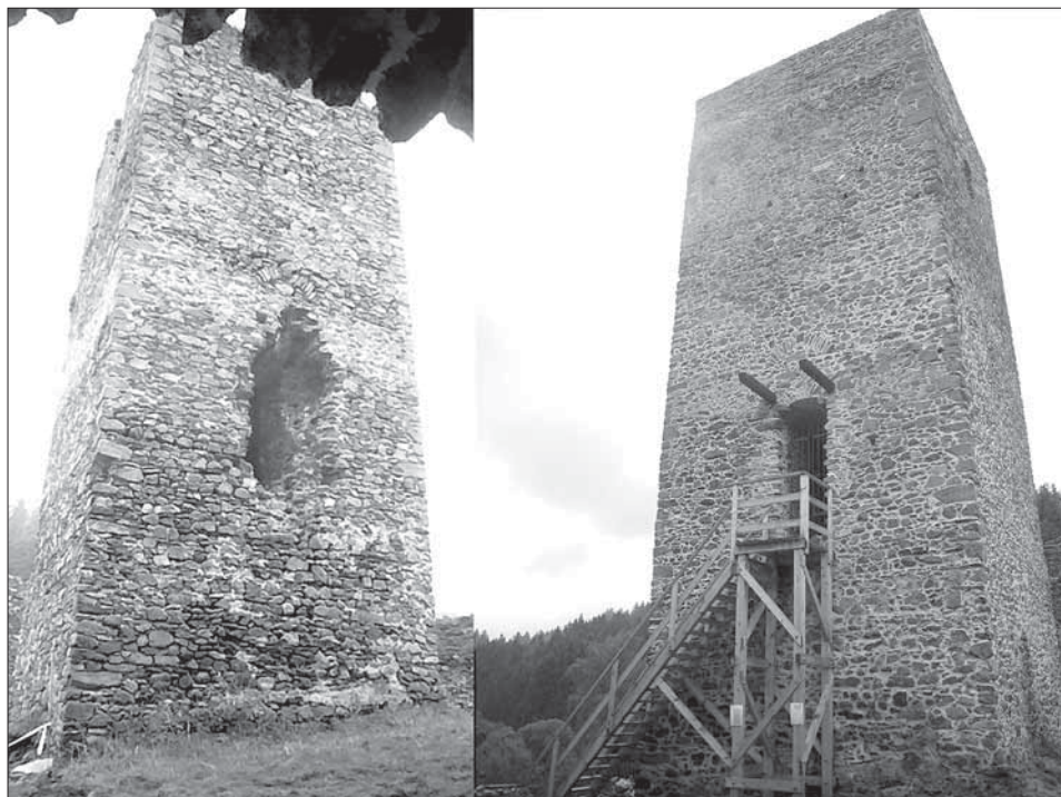
Obr. 22. Horní věž před opravou a po opravě. Schodiště postaveno v místě doloženém archeologickým výzkumem, v původních kapsách osazeny předpokládané konzoly pro zvedání mostku. Abb. 22. Oberer Turm vor und nach der Restaurierung. Die Treppe wurde an der Stelle errichtet, die durch die archäologische Untersuchung belegt ist. Die mutmaßlichen Konsolen für die Zugbrücke wurden in die ursprünglichen Taschen gesetzt.
