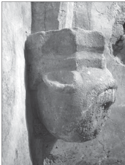
Obr. 6. Uherský Ostroh. Klenební konzola v jižním koutě místnosti.
