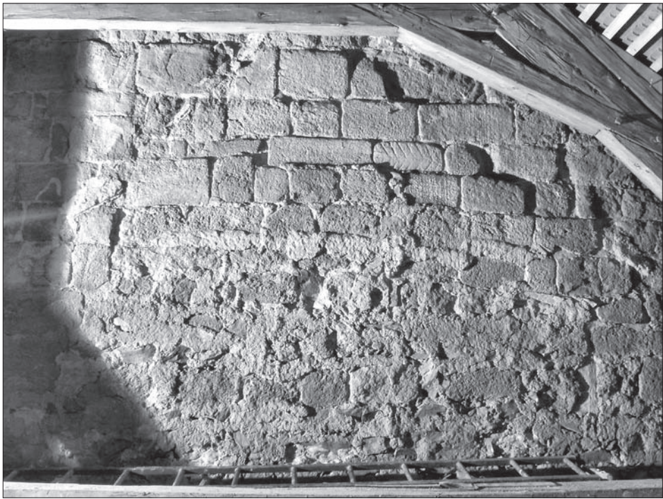
Obr. 1. Svojšíň, kostel. Východní strana věže v podstřeší lodi. Podle Hauserová–Nováček–Čechura–Falta 2011, 12.
