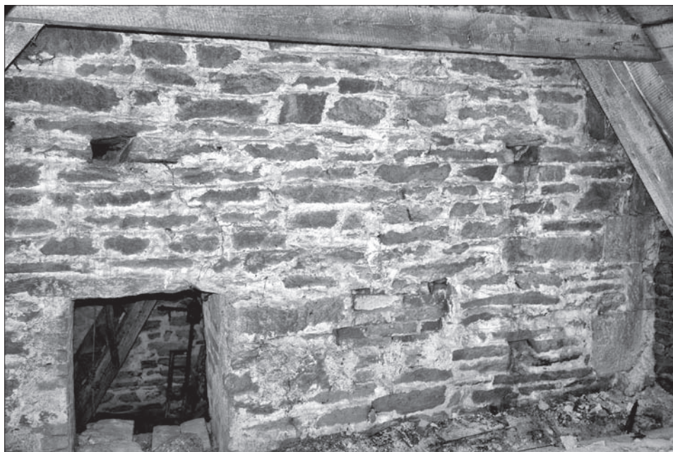
Obr. 2. Pařížov, kostel sv. Máří Magdalény. Pohled z pudy lodi na spodní část východního průčelí věže s rytými spárami. Foto J. Varhaník, 2007.
