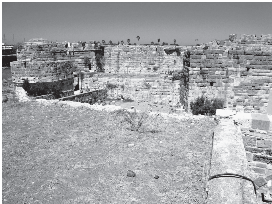
Obr. 12. Kós, čelo jádra hradu Narangie při pohledu přes příhrádek vstupu od jihu. Abb. 12. Kos, Front der Kernburg Narangia, Ansicht durch den Torzwinger von Süden.
