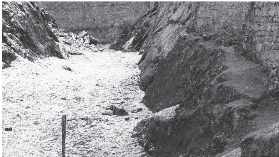
Obr. 8. Hrad Rabí, okr. Klatovy. Pohled na kontreskarpu vnitřního příkopu v západní části hradu od severu. Foto autor, 2007. Abb. 8. Burg Rabí, Bezirk Klatovy. Blick auf die Kontereskarpa des Innengrabens im Westteil der Burg von Norden aus. Foto Verfasser, 2007.
