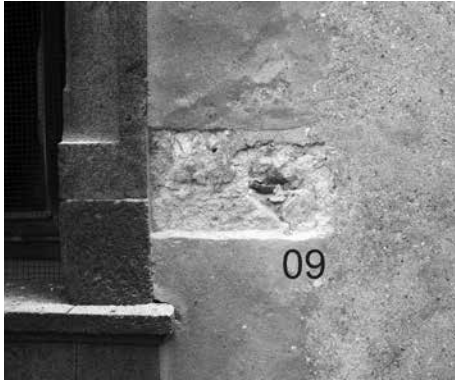
Obr. 15. Košice, Urbanova veža. Sonda 09 (45×26 cm) v strednej časti vedľa kamenného rámu okna druhého poschodia, na západnom priečeli, na pravej (južnej) strane. Abb. 15. Košice, Urban-Turm. Sondierschnitt 09 (45×26 cm) im mittleren Teil neben dem Steinfensterrahmen im zweiten Stockwerk, Westfassade, rechte (südliche) Seite.
