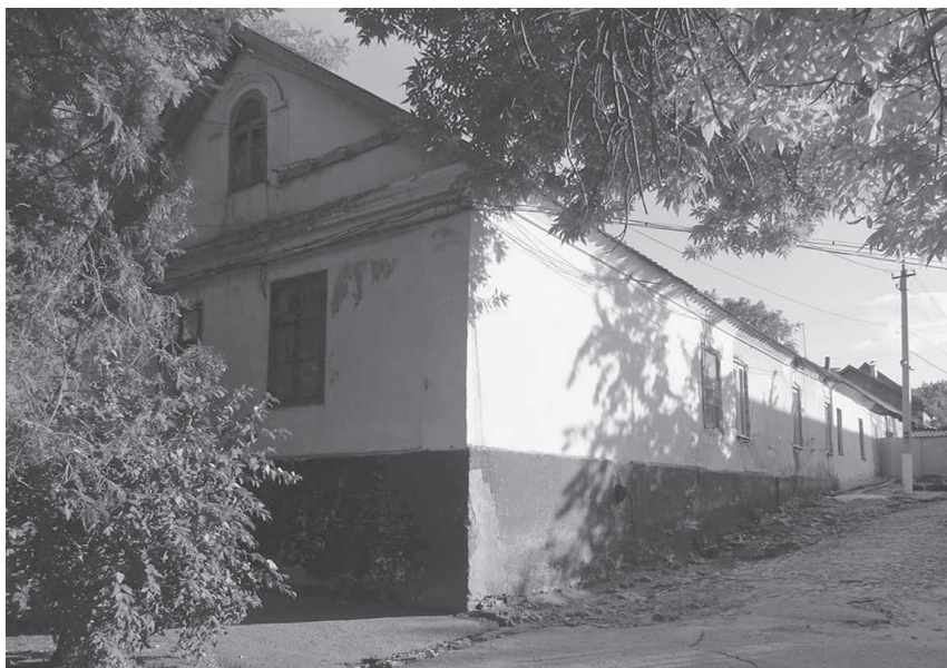
Tarutino – německé stavení (foto autor 2015)
