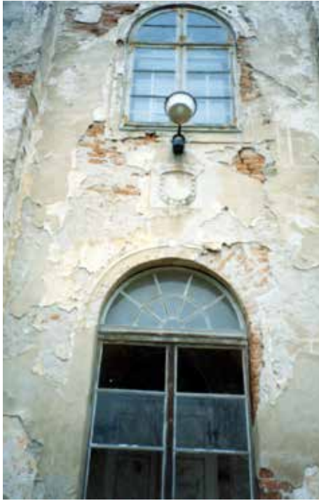
Obr. 7. Jižní průčelí vstupní věže s tesaným erbem, vpravo stopy rýsované rustiky, 1997. Abb. 7. Südfassade des Eingangsturms mit Wappen, rechts Spuren der sich abzeichnenden Rustika, 1997.
