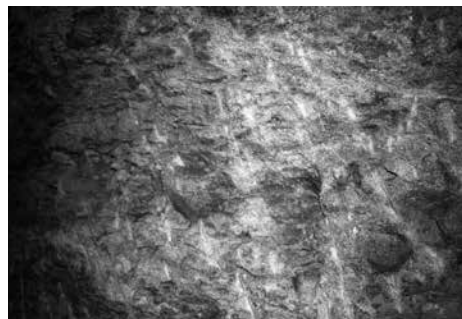
Obr. 16. Krupina, Sládkovičova 14. Pracovné stopy po ručnom kresaní. Foto M. Miňo.
