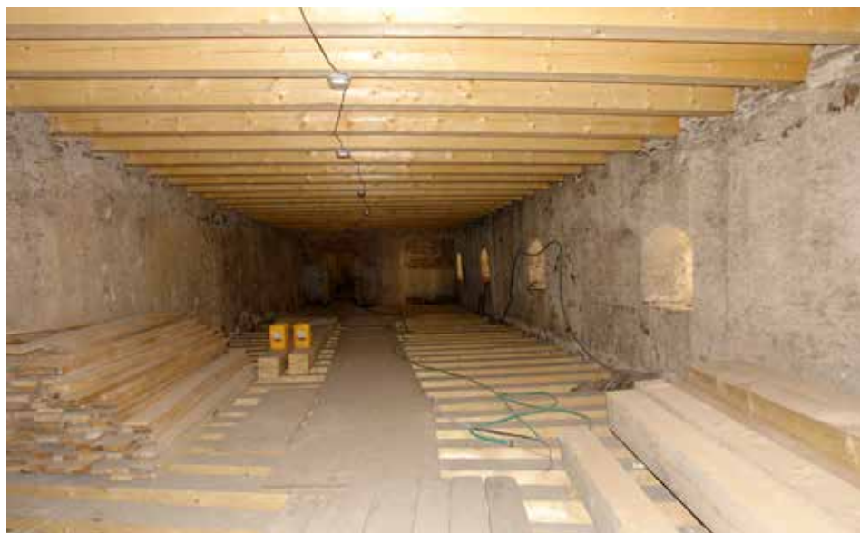
Obr. 7. Hrad Pernštejn, interiér předpokládané sýpky. Foto J. Varhaník, 2008.
