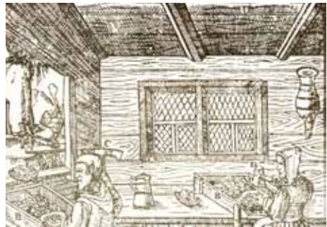
Obr. 7. Detail interiéru třídírny. Podle Hummel a kol. 1933, 234. Abb. 7. Detail des Innenraums einer Sortieranlage. Nach Hummel a kol. 1933, 234.
