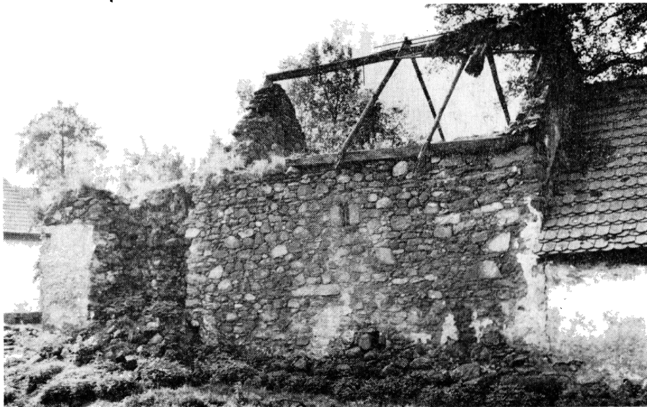
Obr. 7. Strážovice (okres Klatovy), usedlost čp. 10 – zbytky domu. Obytná část domu je už zbořena; stojí zbytky střední části komunikační, přestavěné v 19. století (vlevo) a starší patrová sýpka v zadní části domu. Sýpka je z kamenného lomového zdiva, se šůty, na jejichž ústupky byla usazena dřevohliněná konstrukce lepence. Nad lepencem byl na hřebenové vaznici, zachycené na vrcholech žitíů, zavěšen lehký krov s doškovou krytinou. Foto autor.
