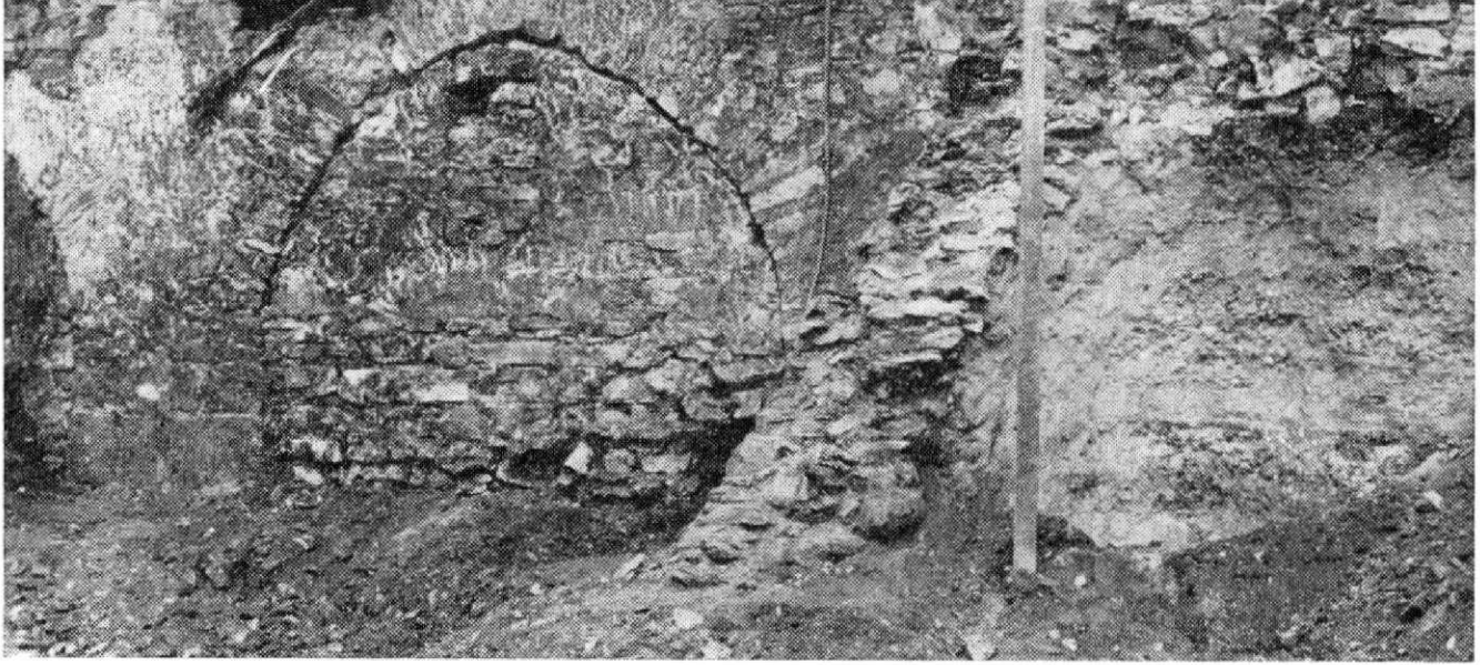
Obr. 2. Pohled na mostní oblouk s piliřem a opěrnou zdí příkopu. Stav před provedením sondy do dna příkopu.
