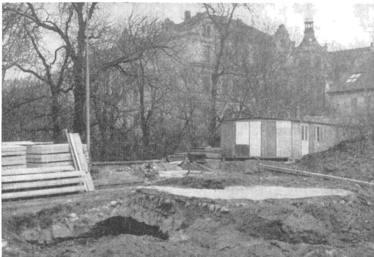
Obr. 9. Praha 6, Bubeneč, Kolkova ulice čp. 6 (demolice). Klenba sklepa a pohled na zkoumanou plochu od JZ. Foto: V. Huml.
