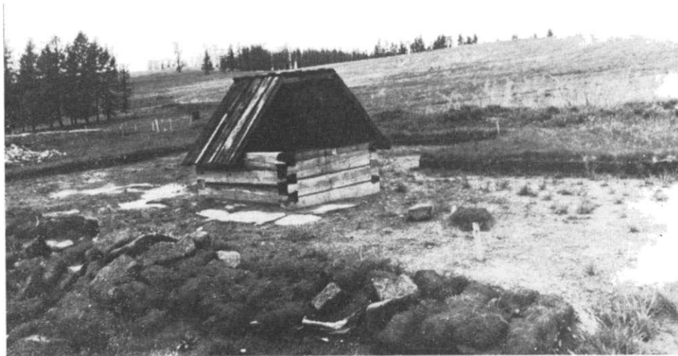
Obr. 6. Pavlany, okr. Sp. N. Ves — Krigov. Rekonštrukcia studne v zaniknutej dedine zo 14.—15. storočia. Foto: F. Javorský.
