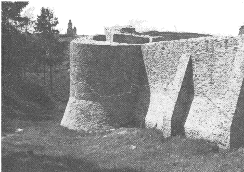
Obr. 3. Suceava (Rumunsko) – příklad rozsáhlé náznakové rekonstrukce hradního opevnění nad archeologicky nalezenými substrukcemi, s odlišením starého a nového zdiva zvýrazněnou párou.
