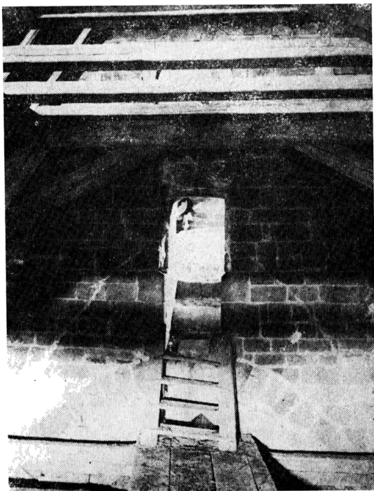
Obr. 8. Západní strana hranolovitého jádra stavby v dnešním podstřeší. Oblouk empory vespod, nad ním vstup do oktogonu a otisk střechy (?) westwerku. Fotoarchiv KSSPPOF Brno.
