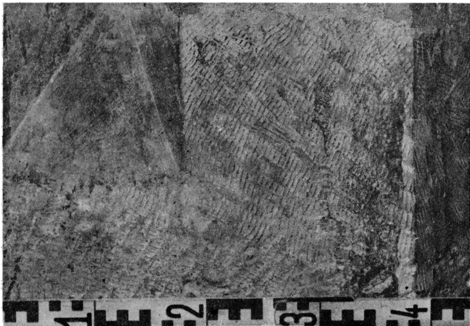
Obr. 3. Pražský hrad, bazilika sv. Jiří, severní věž. Patka oblouku dodatečného průchodu (2. pol. 13. stol.) Příklad opracování povrchu jemnějším zubákem. Kromě krátkých seků jsou znatelné i dlouhé stopy ostří.
