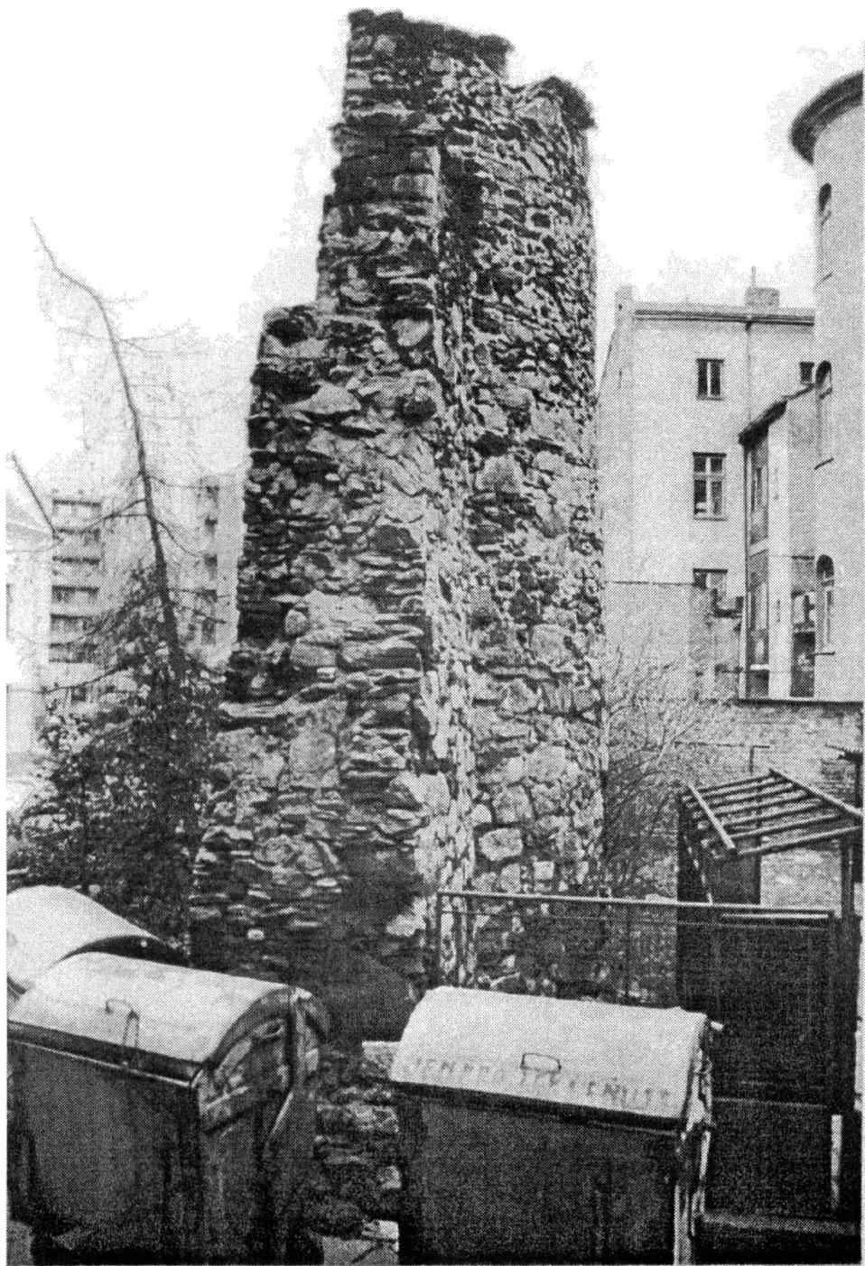
Obr. 1. Charakteristickým prvkem městských opevnění v severovýchodních Čechách a Slezsku bývá mělká dovnitř otevřená hradbní věž. Náchod, pohled na řez hradbní zdi s věží. Foto autor 1992.
