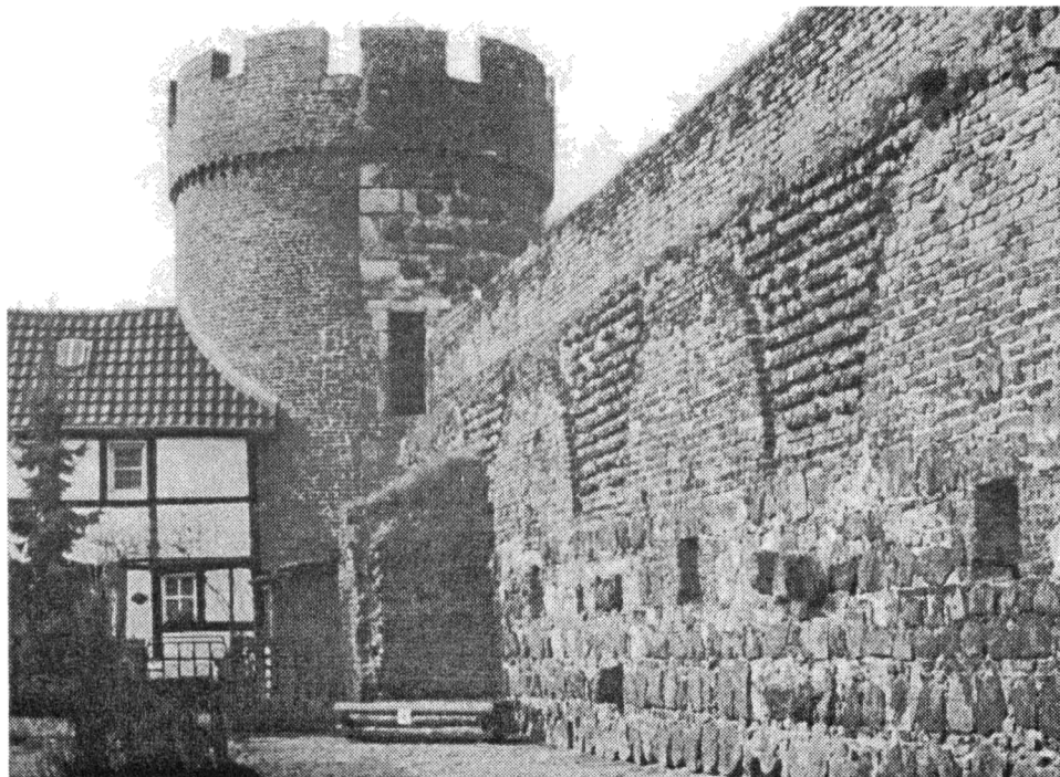
Obr. 6. Oblouky ochozu někdy bývaly připojovány samostatně do předem připravených šmorců. Zons v Porýní, Německo, vnitřní líc městské zdi s nerealizovanými oblouky ochozu. Foto autor 1992.
