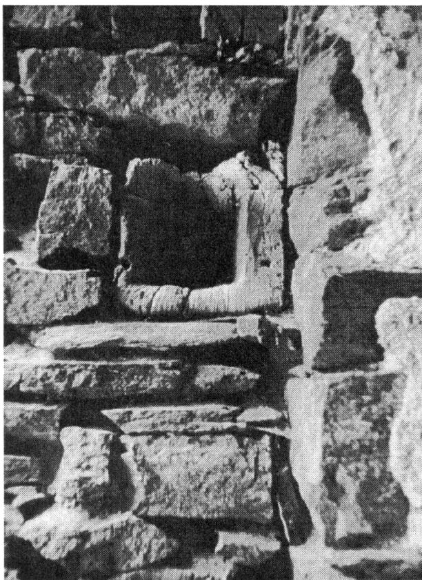
Obr. 10. Bítov, menší břitová věž severního předhradí. Kapsa pro závoru spodního vstupu, umožňující jej uzavřít zvenčí. Foto J. Noll 1994.
