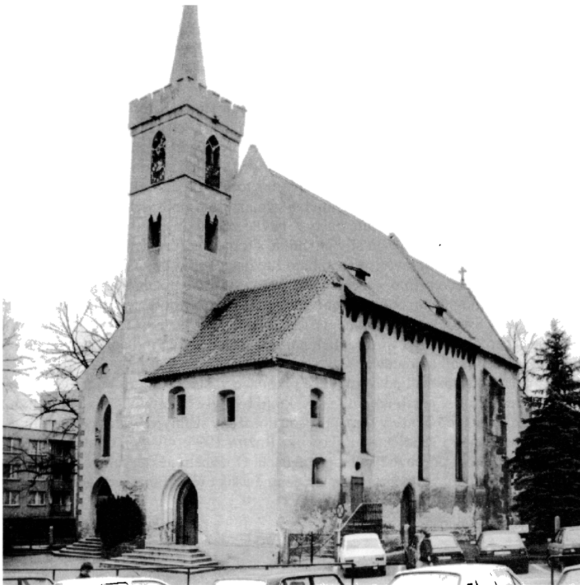
Obr. 13. Sedlčany, kostel sv. Martina, dnešní stav. Pod střechem hlavní lodě dochovány dřevěné příložky s krakorci, které nesly zaniklé obranné polopatro. Foto autor, 1995.
