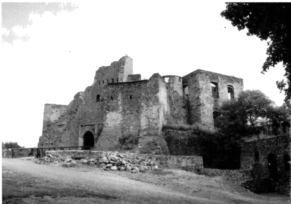
Obr. 4. Podled na hradní jádro Helfenštejna od jihozápadu.
