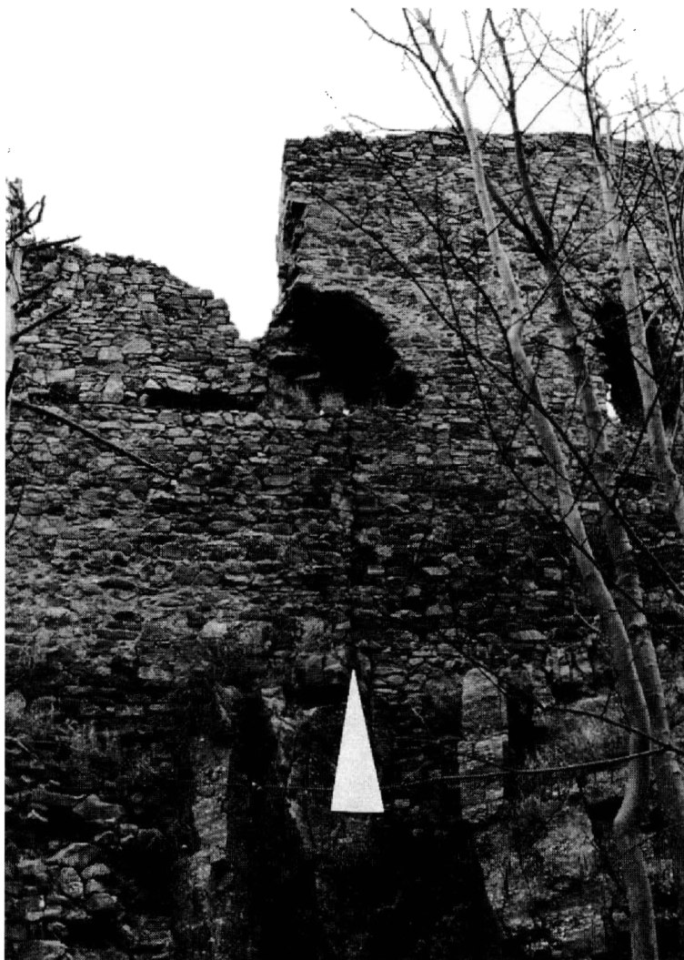
Obr. 12. Valdek, hrad. Pohled na západní spáru mezi starším zdívem paláce a připojenou mladší obvodovou zdí.
