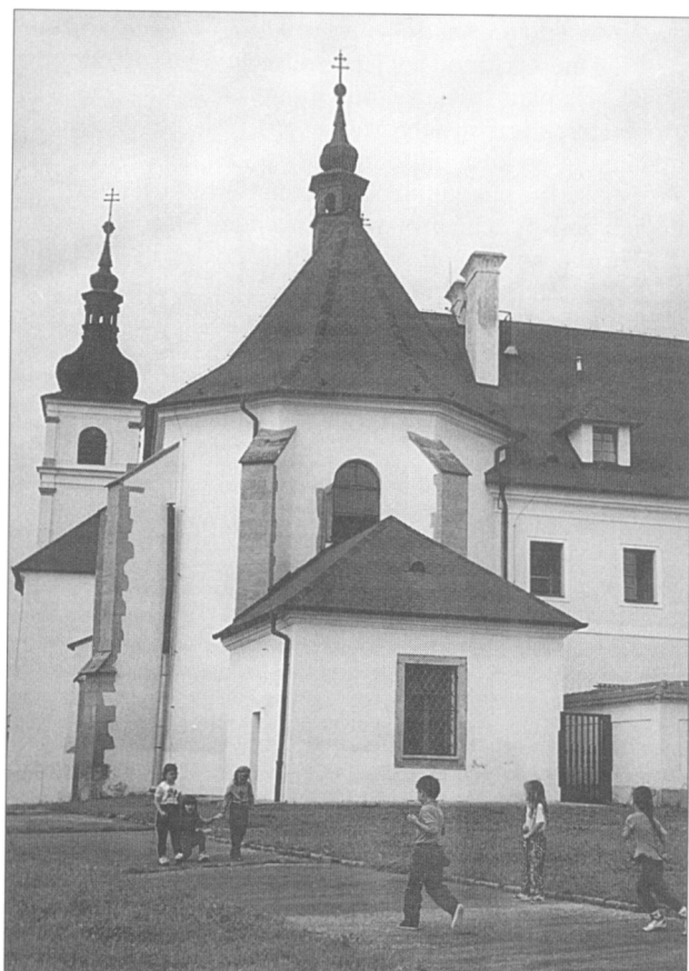
Obr. 19. Uherský Brod, dominikánský klášter – celkový pohled na presbytář klášterního chrámu od východu (foto: R. Vrla 2000).
