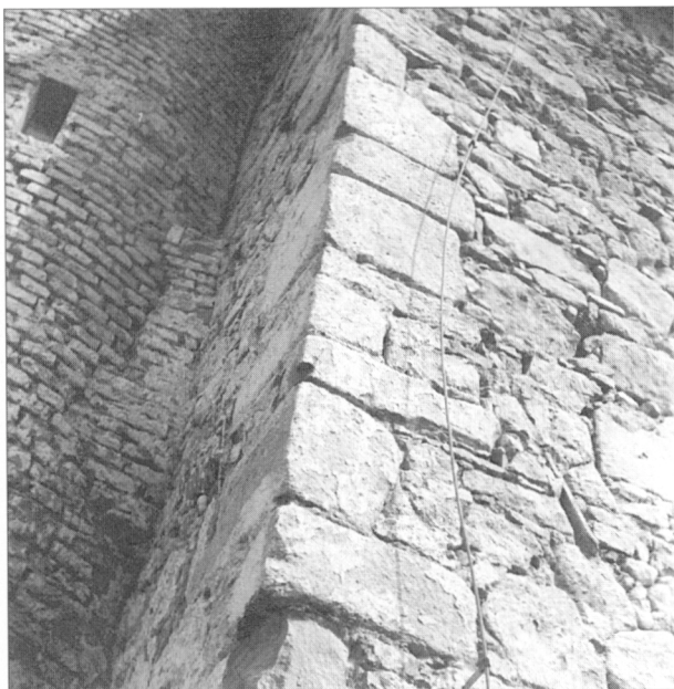
Obr. 2. Pozlovice – kostel sv. Martina; detail jižního nároží kostelní lodi s druhotně použitým gotickým článkem (čtvrtý kvádr odspodu), vlevo cihlové zdivo vřetenového schodiště (stav r. 1985).
