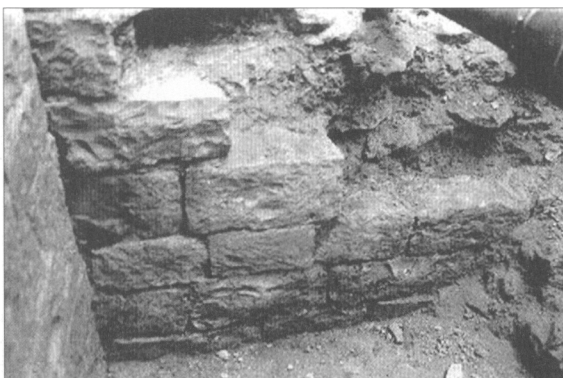
Obr. 2. Praha-Hrad, čp. 2/Tereziánský ústav šlechticů. Zdiva románského objektu v 1. suterénu západní části budovy. Pohled od jihu.
