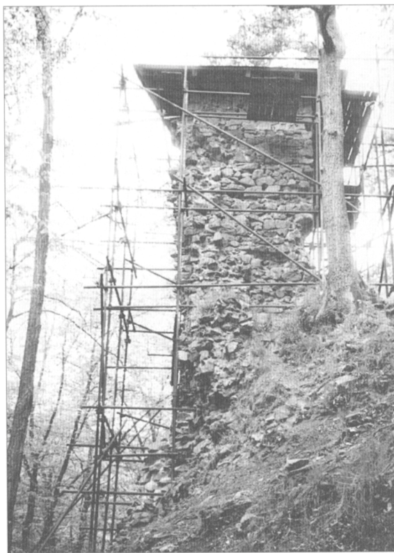
Obr. 3. Zlenice hrad, k. ú. Senohraby, okr. Praha-východ. Pohled od jihovýchodu na před obvodovou hradbu mírně předstupující branskou věž v průběhu její rekonstrukce. Foto T. Durdík.
