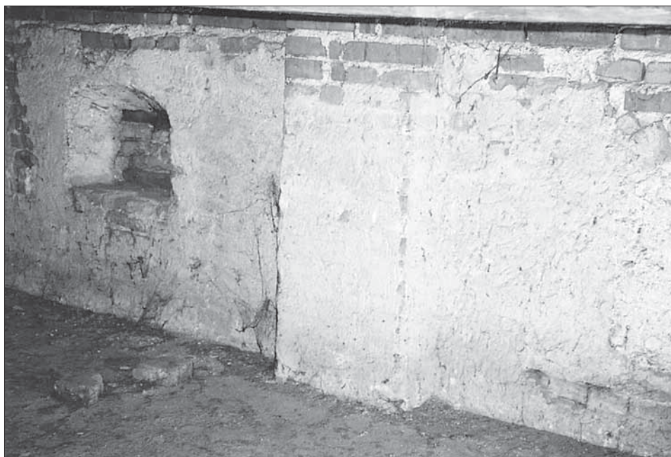
Obr. 2. Zamurované strielne v atike veže, podkrovie. Novoveké doplnky tehlo. Foto Z. Ševčíková.
