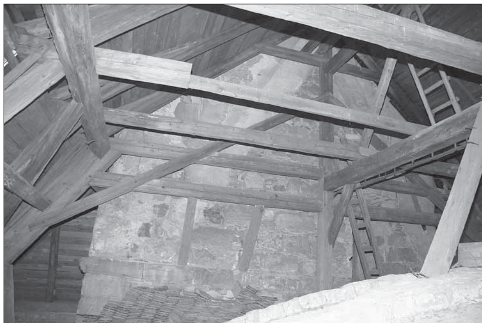
Obr. 6. Stráž pod Ralskem, kostel sv. Zikmunda. Pohled od východu z podkrovní věže na jizvy po štítech staré lodi. Foto I. Peřina, 2007.
