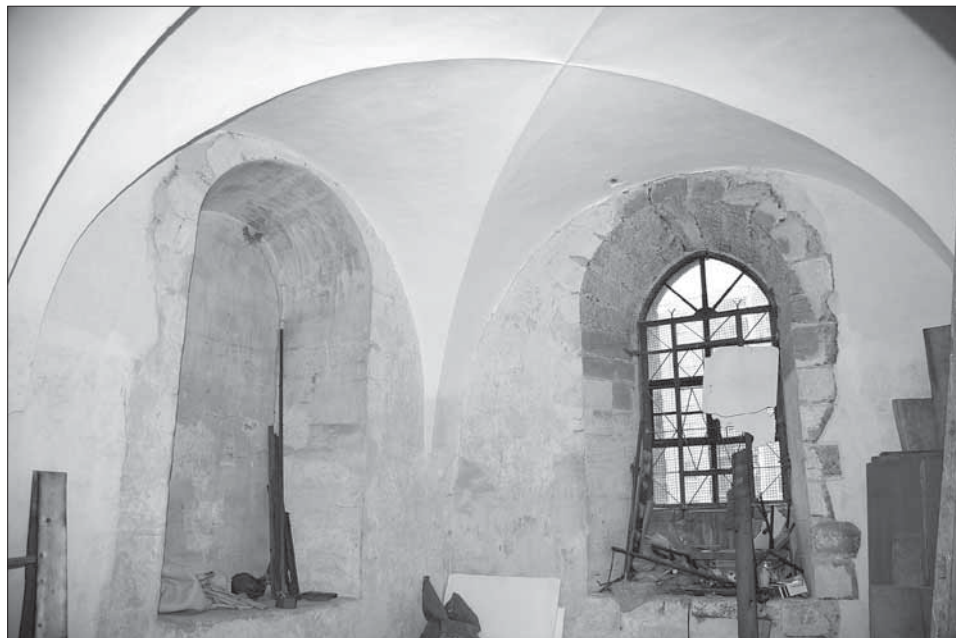
Obr. 5. Stráž pod Ralskem, kostel sv. Zikmunda. Pohled do interiéru prvního patra věže. Foto I. Peřina, 2007.
