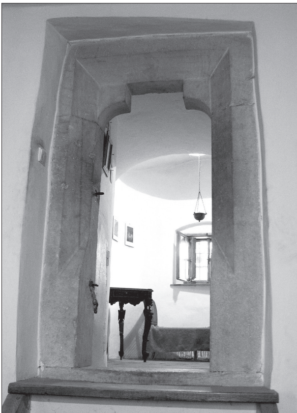
Obr. 8. Hrad Pernštejn; sedlový portálek v interiéru purkrabství, vedoucí do centrální komunikační prostory s útvarem zaniklého vřetenového schodiště.
