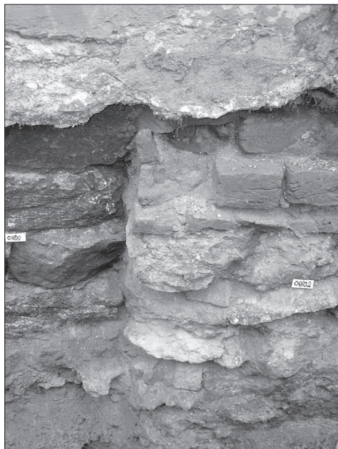
Obr. 5. Předmostí, stavební spára barokní přístavby kostela. Foto Z. Schenk.
