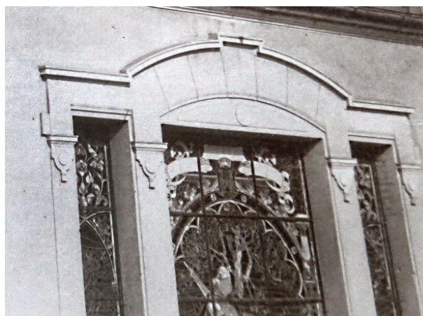
12 – Vitřaž na hlavním schodišti Německého spolkového domu.
