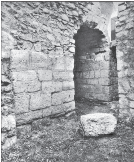
Obr. 5. Murivo Vodnej veže. Abb. 5. Mauerwerk des Wasserturmes.
