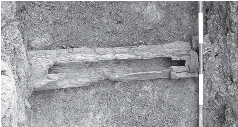
Obr. 13. Pohled na zbytek vodovodu, dřevěné potrubí s železnou spojkou. Podle Hoch 2011, 26.
