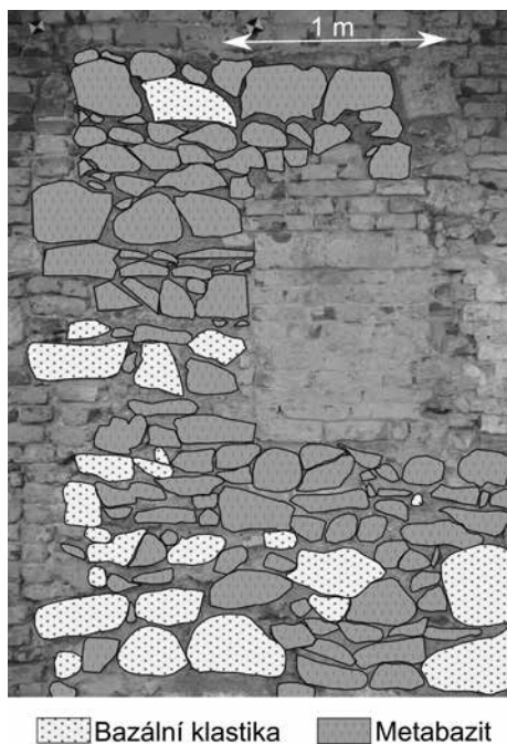
Obr. 2. Metoda měření procentuálního zastoupení jednotlivých druhů hornin. Vzorek JK.
