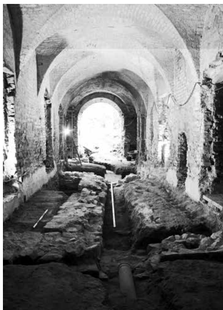
Obr. 13. Dolní Kounice, okr. Brno-venkov. Pohled od severu na substrukce středověkých zdí v chodbě barokního konventu. Archiv Archaia Brno, o. p. s. Abb. 13. Dolní Kounice, Bez. Brno-Land. Blick von Norden auf die Substruktion der mittelalterlichen Gemäuer im Gang des Barockkonvents. Archiv Archaia Brno, o. p. s.
