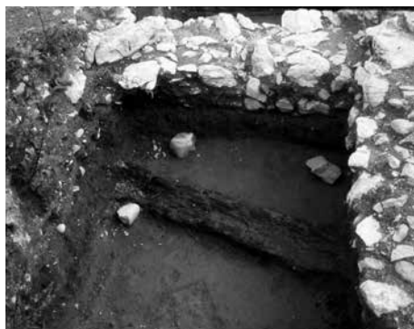
Obr. 13. Banská Bystrica, Námestie SNP č. 3. Odtokový žľab na odvádzanie vody z parcely. Foto M. Mácelová. Abb. 13. Banská Bystrica, Platz des Slowakischen Nationalaufstandes Nr. 3. Abflussrinne zum Ableiten von Wasser von der Parzelle. Foto M. Mácelová.
